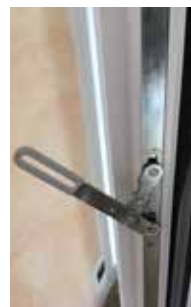
Verrou toute hauteur Pour déverrouillage semi-fixe oscillo-battant
