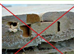
Ne pas insérer de tasseau entre les lames
